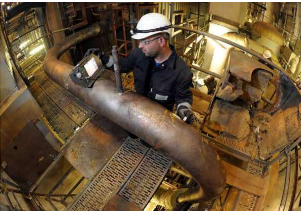
Einsatz im Kraftwerk während eines Anlagenstillstandes
