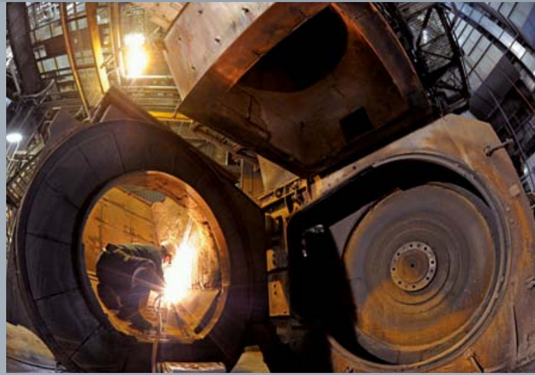
Schneidarbeiten an der Abgasanlage (Foto: Andreas Seidel, Chemnitz)
