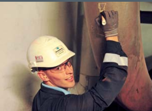
Vorbereitende Maßnahmen zur Bauteilmetallographie: Schleifen und Polieren einer vorher definierten Messstelle
