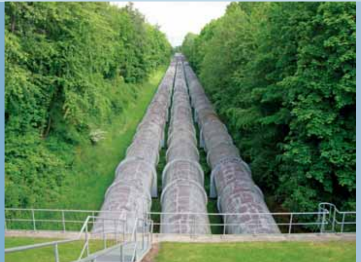
Talseitige Röhren des PSW Niederwartha
