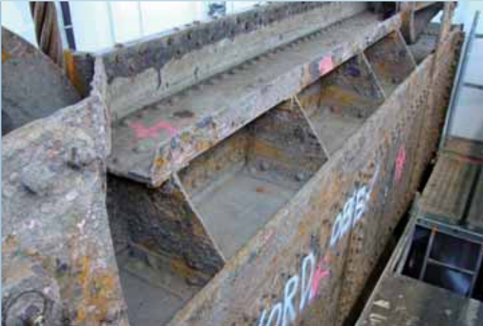
Oberlauf des Einlaufschützes
