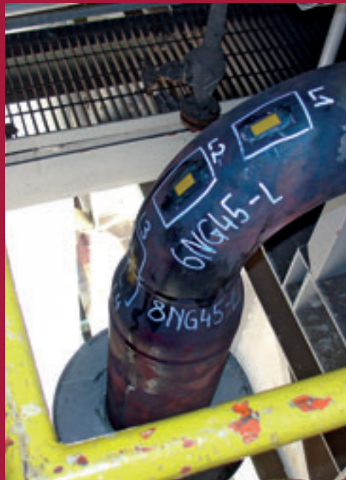
Replica-Untersuchung an einem Rohrbogen
