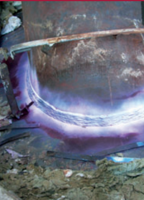
Oberflächenrisssprüfung an einer Schweißnaht
