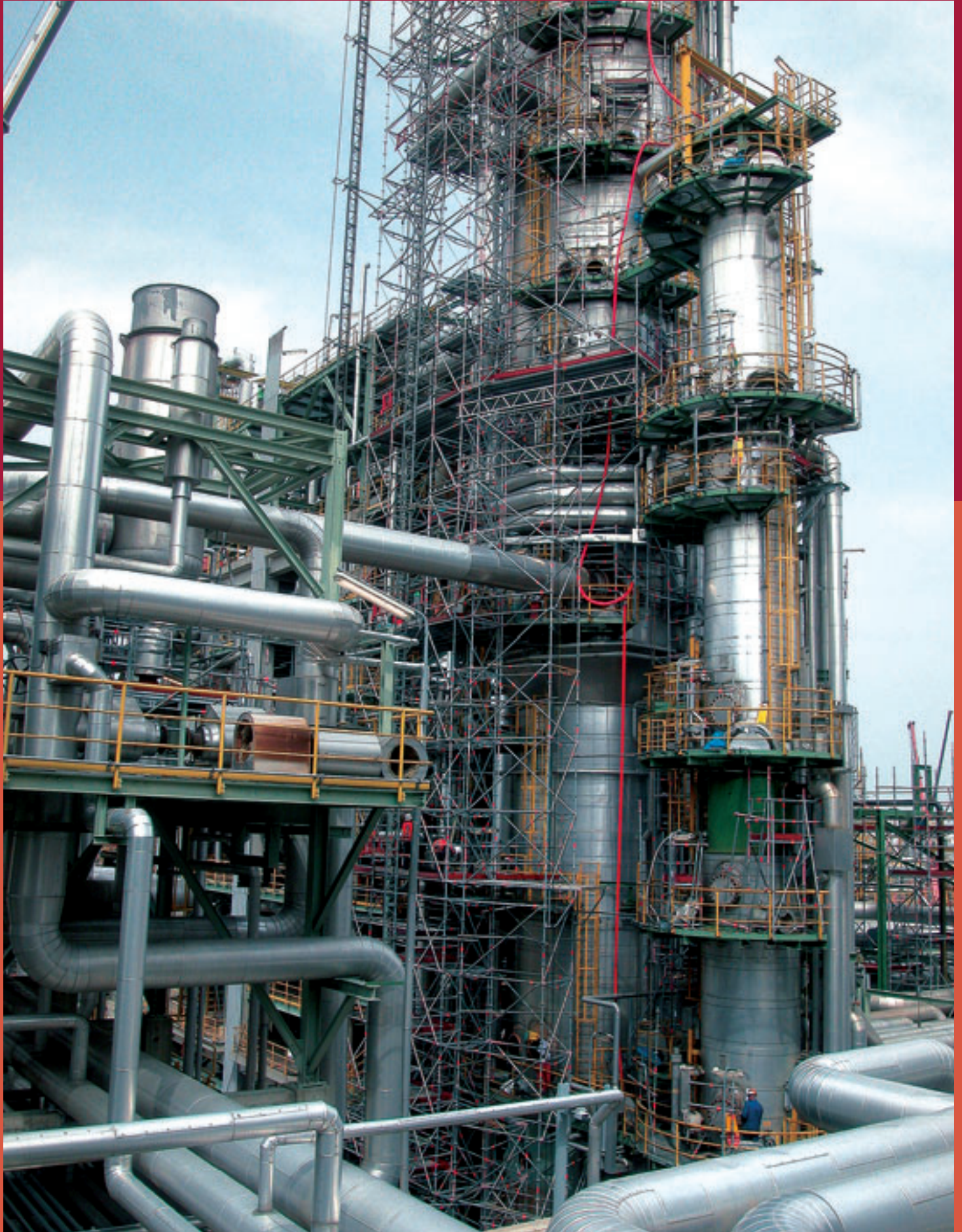
Prüf- und Inspektionsarbeiten im Außenbereich der TOTAL Raffinerie
